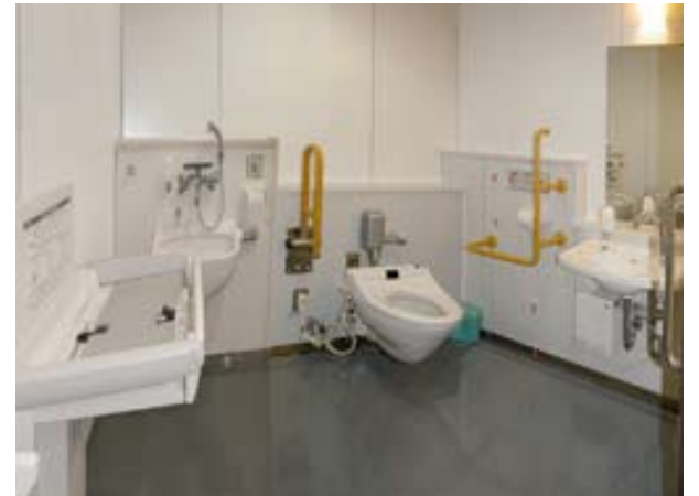
16 多目的トイレ(みんなのトイレ)では、身体に障がいをもった人、小さな子ども連れの親なども使えるようにつくられている。ただし、スペースの制約があるサポートセンターの多目的トイレでは、その中で車イスに乗ったまま回転することは難しく、10階(こちらには介護用ベッドもある)のトイレを利用してもらうことになる。また、便器脇の手すりは、9階では左側、10階では右側に設置し、どちらか便利な方を使用してもらえるようにした。その情報は、施設の利用案内パンフレットやホームページにも掲載している。
